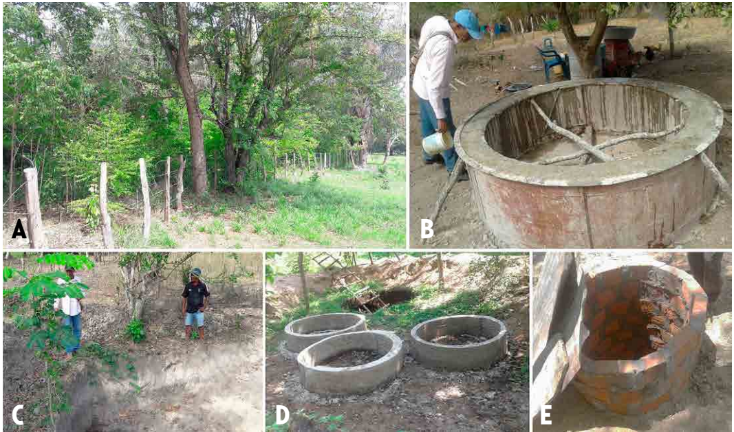
Figura 6. Implementación de cercas vivas, abrevaderos para el ganado y mejoramiento de pozos artesianos. Ejemplo de plantación de Gliricidia sepium por estacas, la plantación se realizó a 70 cm de distancia hacia el interior de las cercas de alambre establecidas por el proyecto (A). Ejemplo de abrevadero “tipo anillo” para controlar factores tensionantes (e.g. pisoteo y/o ramoneo del ganado) sobre la regeneración natural en ronda hídrica (B). Estado inicial de algunos puntos de captación de agua, obsérvese la inexistencia de infraestructuras para facilitar la recolección del agua (C). Proceso de construcción de la base del pozo a través de anillos de concreto (D). Parte superior del pozo aún sin acabados finales (E).
