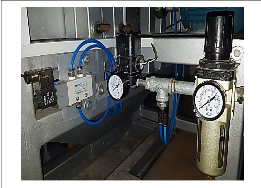
Figura 44. Instalación de los elementos neumáticos [Autor].
