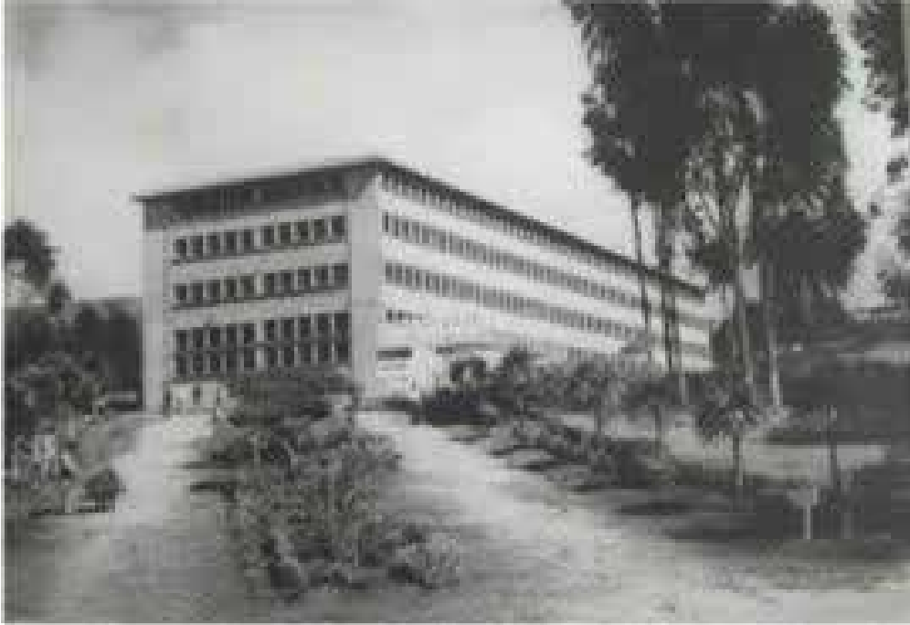
Figura 67. Edificio Laboratorios UPTC.
