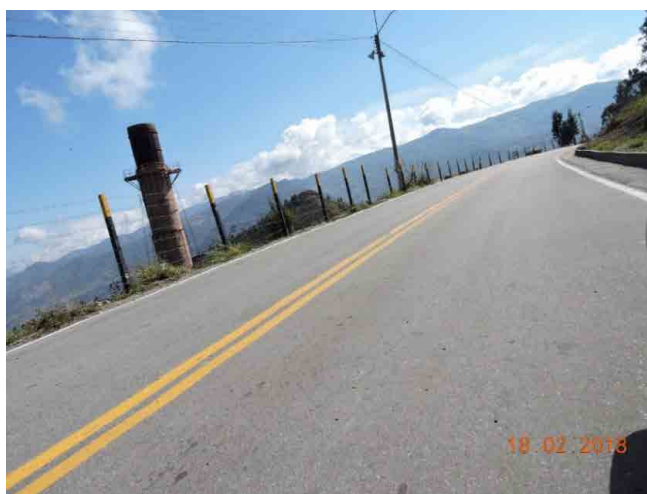
Figura 2-13 Abscisa PR40+100 – Estado del tramo bueno, no presenta daños relevantes
