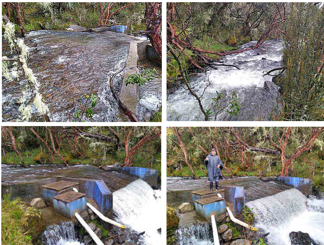
Figura 3.30 Fuente de abastecimiento y estructura de captación Acueducto El Romero, Municipio de Güicán
