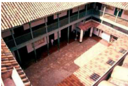
Foto. Fotografía vista aérea Escuela Superior de Música de Tunja
