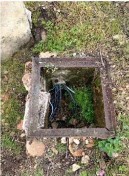
Caja de inspección de energía. Con cables de baja tensión expuestos
