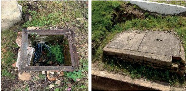
**Imagen 171. (izq) Caja de inspección de energía con cables de baja tensión expuestos. Imagen 172. (der) Caja de inspección de energía con capa vegetal.** Fuente: Equipo PEMP 2017
