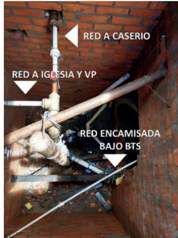
Imagen 163. Pozo de Inspección adyacente a vía BTS
