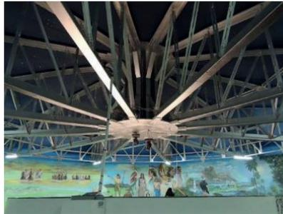
**Imagen 266. Estructura de cubierta y espacio segundo nivel del Ciclorama**
