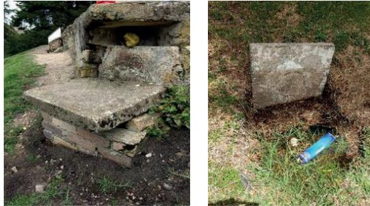
Imágenes 198 y 199. Cajas de inspección agua con deterioro medio y alto.
