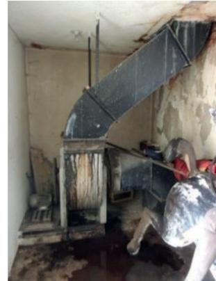
**Imagen 253. Equipos de extracción de aire del restaurante**
