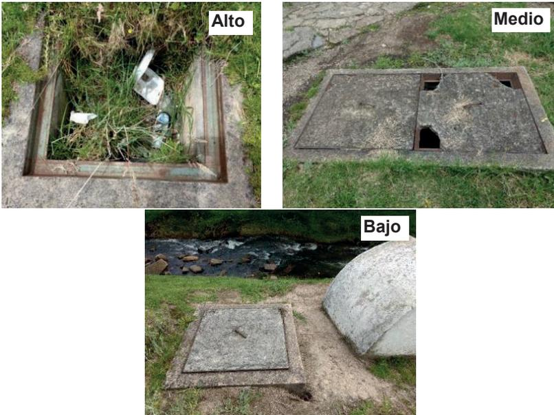
**Imagen 166 Cajas de inspección energía con deterioro alto, medio y bajo**
