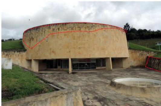
**Imagen 262. Acumulación de suciedad en fachada, muros y pisos de exteriores del Ciclorama.**
