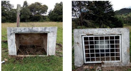
Imagen 187 y 188. Luminarias tipo 3 iluminación conjuntos monumentales – sin lámpara y con lámpara. Fuente: Equipo PEMP 2017
