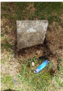
Cajas de inspección agua – Estado de deterioro alto.
