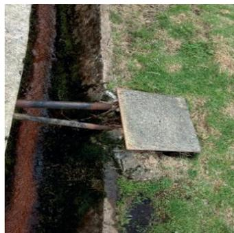
Imagen 197. Cajas de inspección agua con tapa
