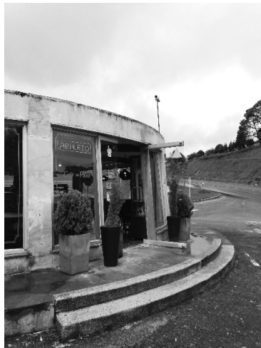
Imagen 52. Acceso por escaleras al Kiosco, no cumple para discapacitados. Fuente: Parra, G., Gonzales, D., Rojas, G., 2017.
