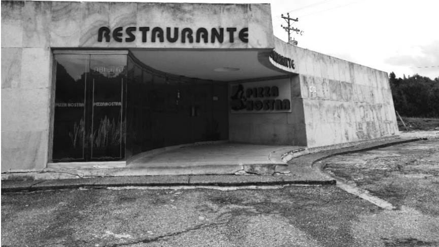
Imagen 53. Acceso inadecuado al restaurante. Fuente: Parra, G., Gonzales, D., Rojas, G., 2017.
