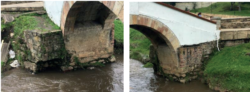
Imagen 327 y 328. Estado del Puente de Boyacá. Fuente: Equipo PEMP.
