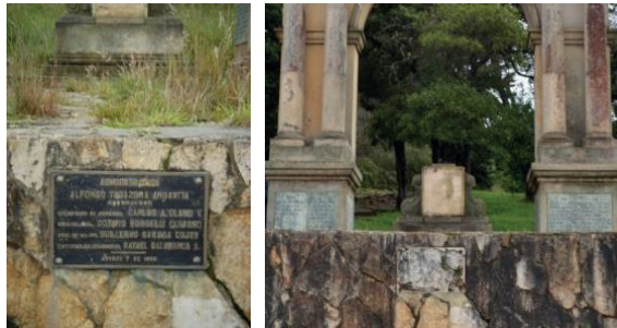
Imágenes 305 y 306. Se observa la placa que estaba instalada en la parte frontal de la estructura de acceso a arco y el espacio sin la placa actualmente. Fuente: Izq. Eduardo Malagón; der. Equipo PEMP 2017.
