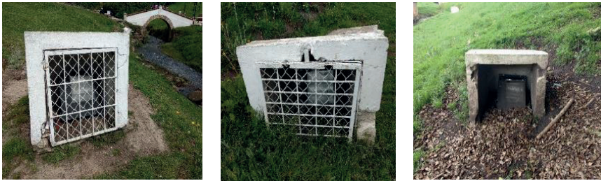
Imagen 184, 185 y 186. Luminarias tipo 3 iluminación conjuntos monumentales – Nivel de deterioro bajo, medio y alto. Fuente: Equipo PEMP 2017
