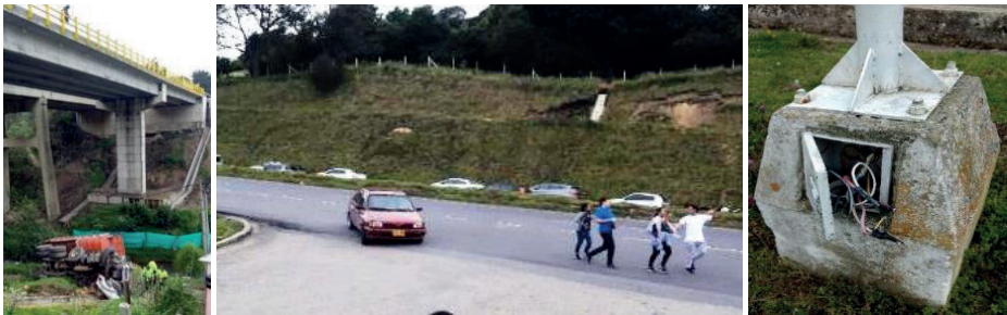
Imágenes 524 y 525. Situaciones de riesgo por carencia de infraestructura adecuada. Fuente: Equipo PEMP 2017.
