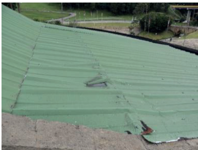
Imágenes 251 y 252. Detalles del estado actual del manto de cubierta restaurante
