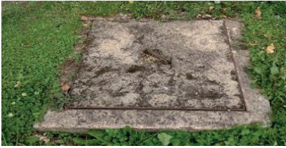
Imagen 167. (izq): Cajas de inspección Sin identificación serial. Imagen 168. (der) Cajas con identificación. Fuente: Equipo PEMP 2017
