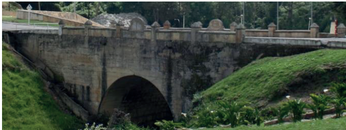
Imagen 232. Puente de Calicanto. Fuente: Equipo PEMP 2017.
