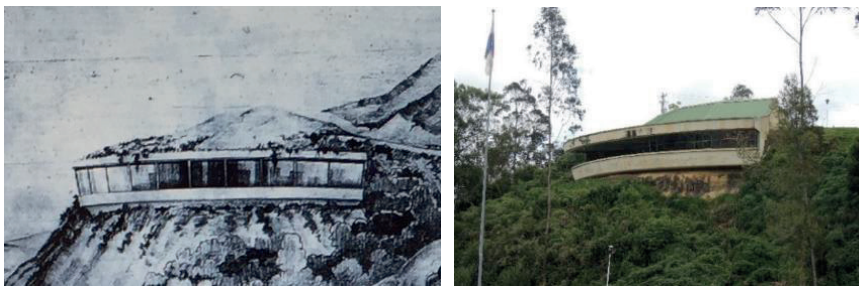
Imágenes 242 y 243. Propuesta y fachada actual del Restaurante
