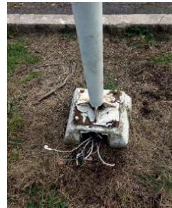
Imagen 179. Luminaria ornamental tipo 1–oxidación media. Imagen 180. Luminaria ornamental tipo 1 con oxidación alta. Fuente: Equipo PEMP 2017
