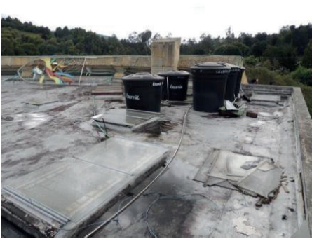
Imágenes 249 y 250. Cubierta del restaurante y filtraciones de los cielorrasos.
