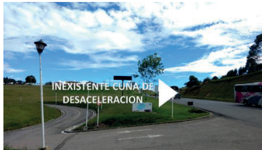
Imagen 144. Inexistencia de cuña de desaceleración – acceso SH sobre BTS
