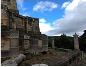
Desplome de columna de pedestal de Obelisco y robo de luminarias
