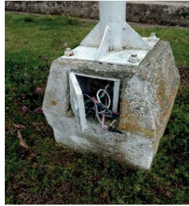
Imagen 173. Luminaria ornamental tipo 1 sin tapa. Imagen 174. Luminaria ornamental tipo 1 con tapa de registro. Fuente: Equipo PEMP 2017
