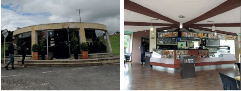
Imágenes 270 y 271. Quiosco al acceso del sitio histórico. Fuente: Equipo PEMP 2017
