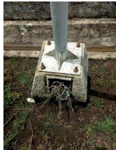
Imagen 179. Luminaria ornamental tipo 1–oxidación media. Imagen 180. Luminaria ornamental tipo 1 con oxidación alta. Fuente: Equipo PEMP 2017
