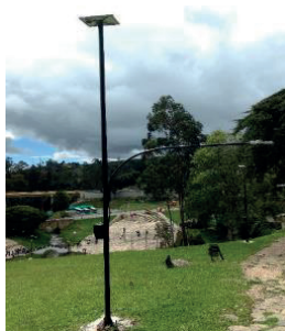
Imagen 182. Luminarias tipo 2 con paneles fotovoltaicos – Nivel de corrosión bajo. Imagen 183. Luminaria tipo 2 con paneles fotovoltaicos con nivel medio de corrosión. Fuente: Equipo PEMP 2017
