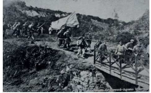
Imagen 324 y 325. Puente con riostras de madera, construido para conmemorar el Centenario de la Batalla de Boyacá el 7 de agosto de 1919. Fuente: Archivo Privado Siervo Tulio Molano.
