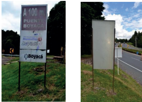
Imagen 412 y 413. Señalización en la vía, producida por la Gobernación de Boyacá. Fuente: Equipo PEMP 2017.
