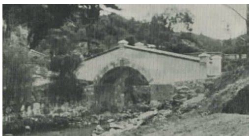
Imagen 45. Puente de Boyacá remodelado sobre los estribos antiguos. Fuente: Fotografía: Eusebio Santamaría 1940.
