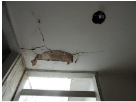
Imágenes 249 y 250. Cubierta del restaurante y filtraciones de los cielorrasos.
