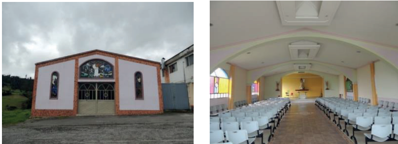
Imágenes 222 y 223. Interior y exterior de la Antigua Capilla del Puente de Boyacá Fuente: Equipo PEMP 2017.
