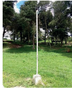
Imagen 175. Luminaria ornamental tipo 1 - poste inclinado. Imagen 176. Luminaria ornamental tipo 1 con ausencia de lámpara. Fuente: Equipo PEMP 2017
