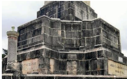
Imagen 300. En esta fotografía se observan varias de las placas que han sido instaladas en el obelisco. Fuente: Equipo PEMP 2017.
