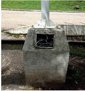
Imagen 173. Luminaria ornamental tipo 1 sin tapa. Imagen 174. Luminaria ornamental tipo 1 con tapa de registro. Fuente: Equipo PEMP 2017
