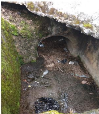
Red de Aguas Lluvias – Estado Actual
