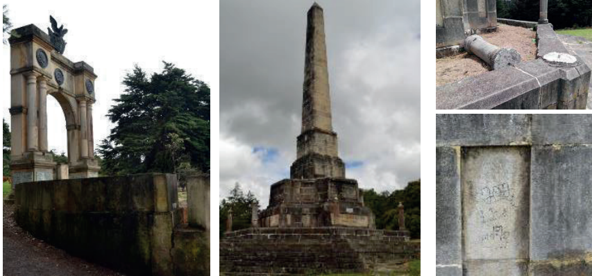
Imágenes 505, 506, 507 y 508. Estado de monumentos. Fuente: Equipo PEMP 2017.
