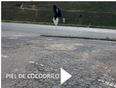
Imagen 155. Patología zona de parqueo. Piel de cocodrilo y cabeza dura Fuente: Equipo PEMP 2017
