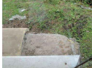
Imágenes 254 y 255. Afectaciones sobre la piedra y desprendimientos Fuente: Equipo PEMP 2017
